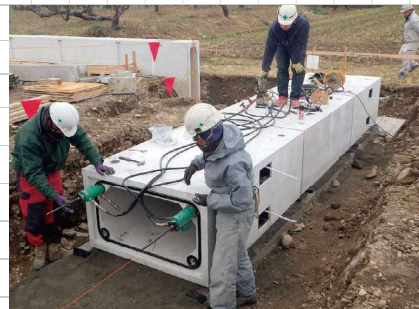
■ 製品縦締め状況 (PC縦締めタイプ)
