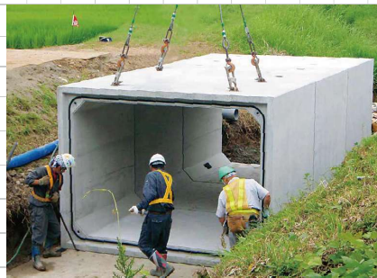
■ 製品据付状況
